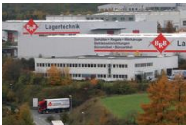
Bild: Hauptsitz BRB-Lagertechnik in Wenden (Quelle: BRB)
