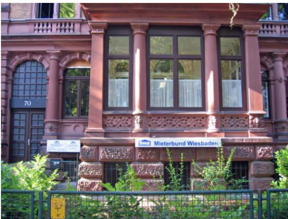
Bild: Büroräume Mieterbund Wiesbaden, Adelheidstr. 70
